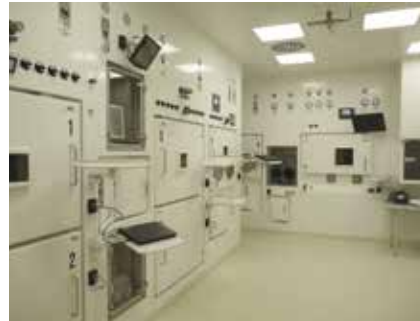
Neues Reinraumlabor mit vollabgeschirmten Heißzellen für die Radiopharmakaproduktion unter GMP-Bedingungen.
