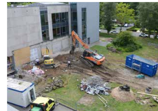
Baubeginn an der Brahmsstraße in 2024.
