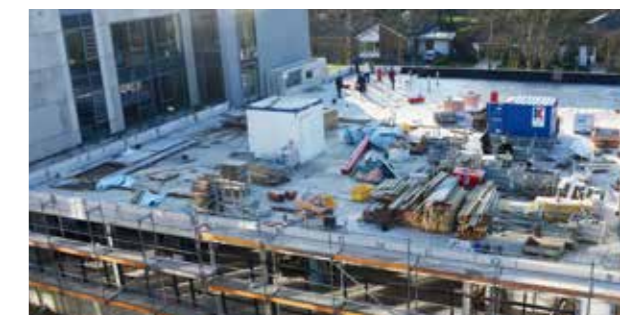
Eine Aufnahme vom Februar 2025. Im Anbau entstehen hier zwei weitere Operationssäle.
