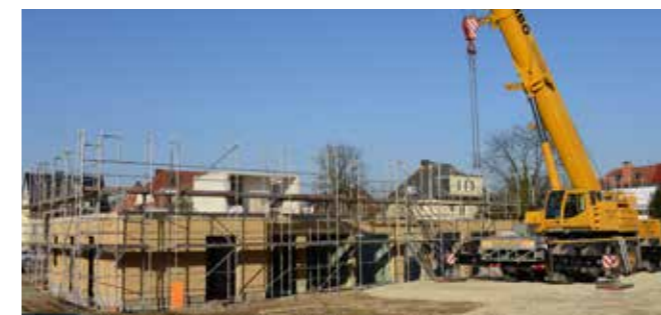
Grundstück an der Uhlandstraße im März: Das erste Stockwerk der zukünftigen Kita steht bereits.
